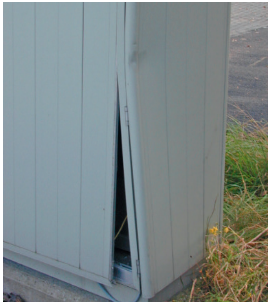
Afbeelding 1: Vervormde kast na inwerking mechanische kracht
